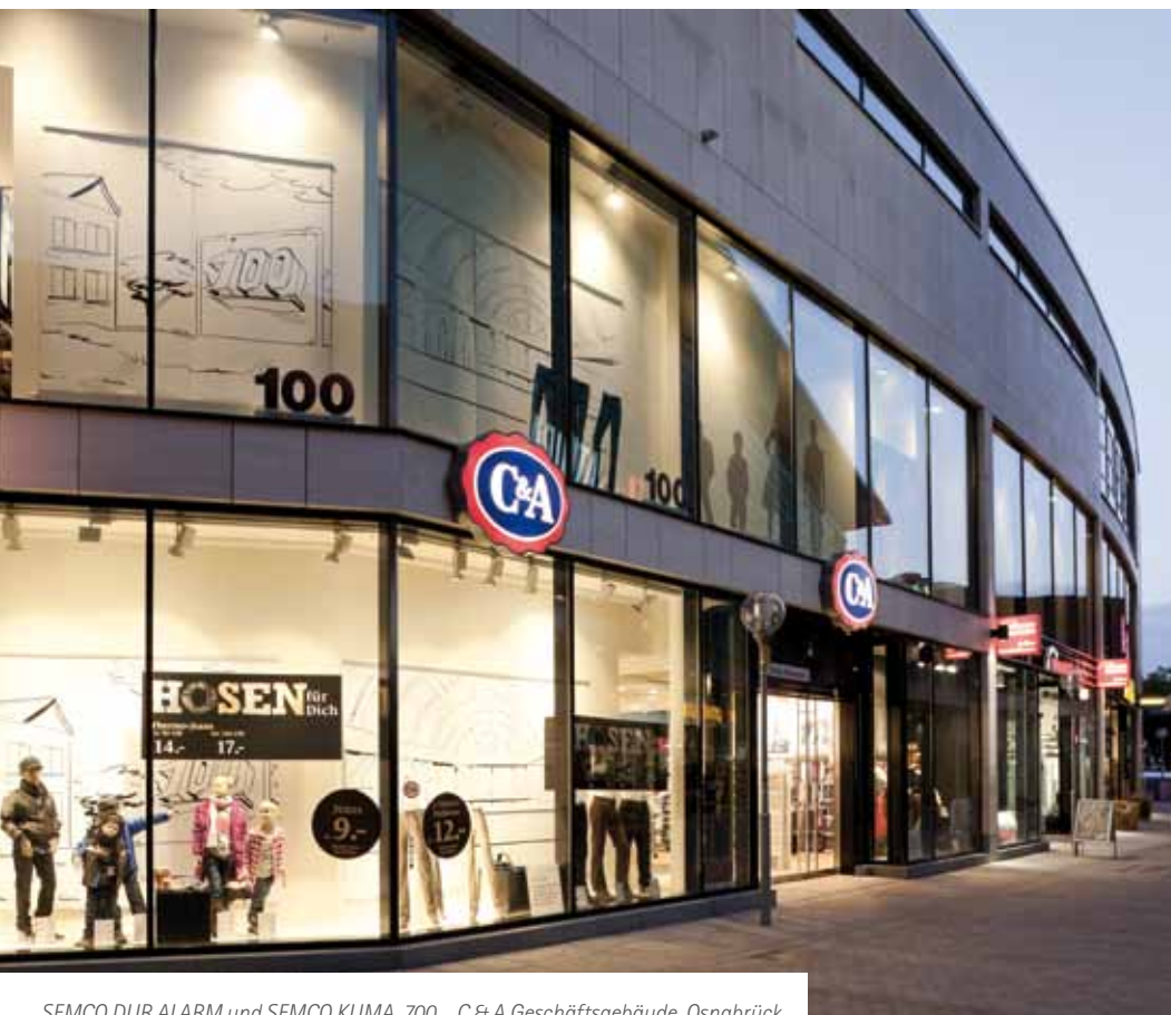
SEMCO DUR ALARM und SEMCO KLIMA 700_ C & A Geschäftsgebäude, Osnabrück
