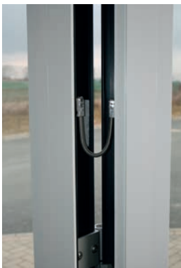
Abb. 10.32: Kabelführung Rahmen – Flügel
