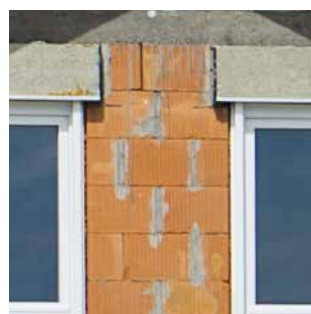
Detailansicht Neubau-Auflagerkasten, Mauerwerk mit beidseitigem Auflager
