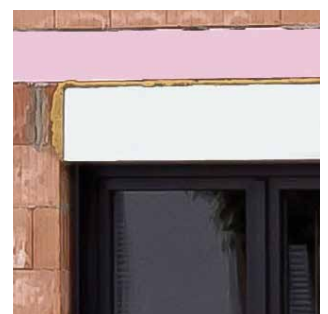
Detailansicht Aufsatzkasten, Mauerwerk als einfache Öffnung ohne Auflager
