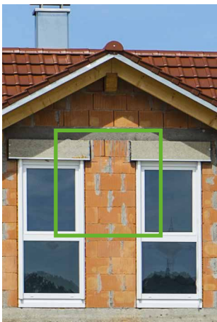
Detailansicht Neubau-Auflagerkasten, Mauerwerk mit beidseitigem Auflager
