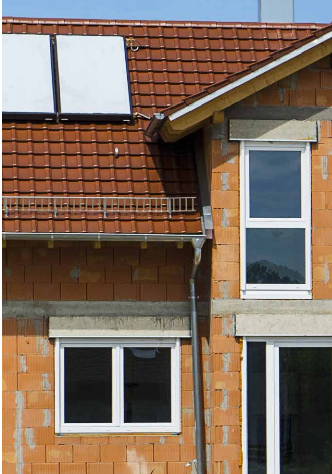
Neubau-Auflagerkasten: Ansicht im Rohbau montiert
