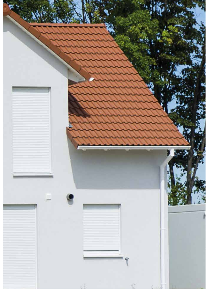
Neubau-Auflagerkasten: Ansicht mit verputzter Fassade
