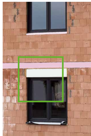
Detailansicht Aufsatzkasten, Mauerwerk als einfache Öffnung ohne Auflager
