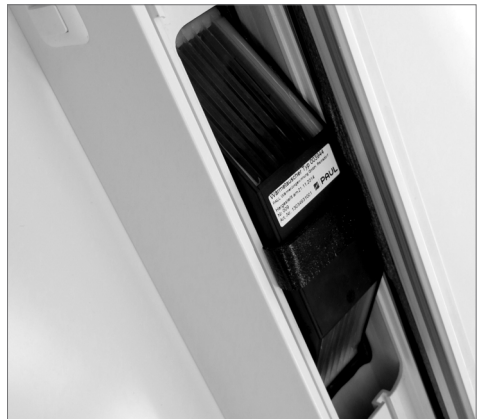
Ausrichten des Wärmetauschers
