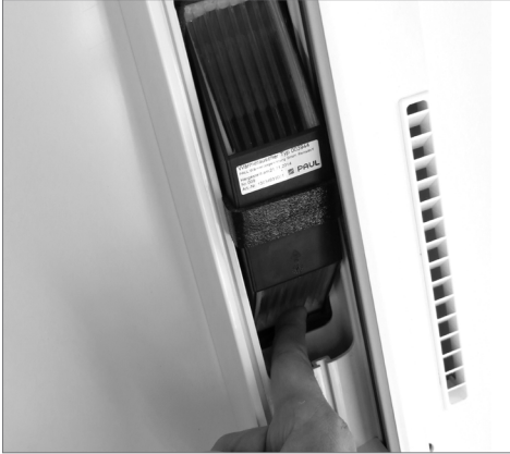
Herausziehen des Wärmetauschers
