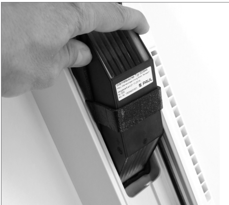
Einsetzen des Wärmetauschers
