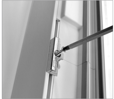
Verschrauben der Schließstücke
